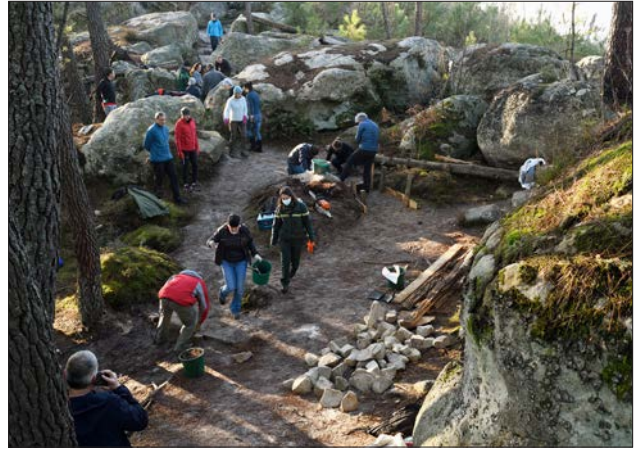
Réalisation d'un chantier de lutte contre l'érosion (2021 et 2022) © ONF
