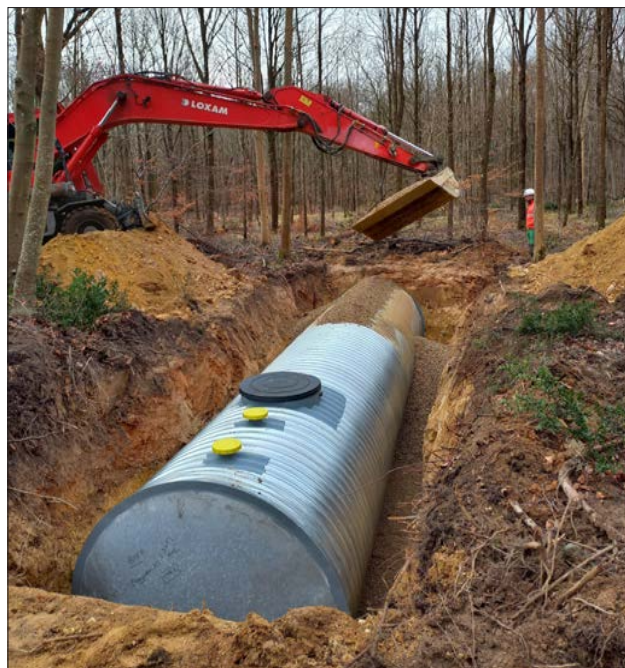
Installation d'une citerne enterrée © ONF (2022)
