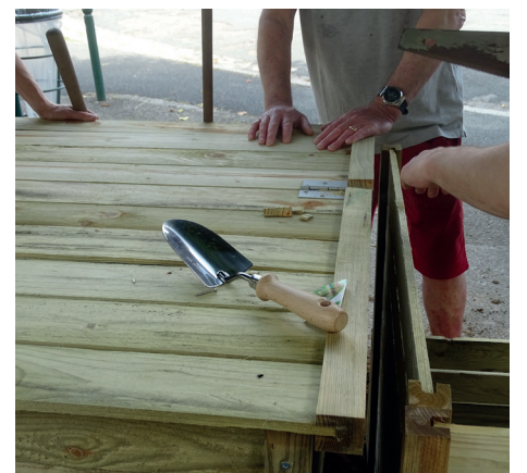
↑ CONSTRUCTION ET INSTALLATION D'UN COMPOSTEUR DE QUARTIER
